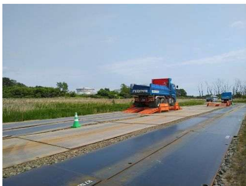
タイヤ洗浄装置を複数台設置。また道路汚損を防止するため日々、散水車による清掃活動を実施
