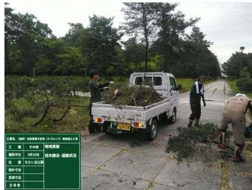
モエレ沼公園 伐採木の積み込み、搬出
