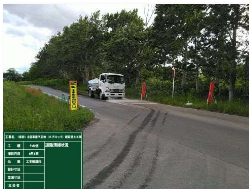
タイヤ洗浄装置を複数台設置。また道路汚損を防止するため日々、散水車による清掃活動を実施
