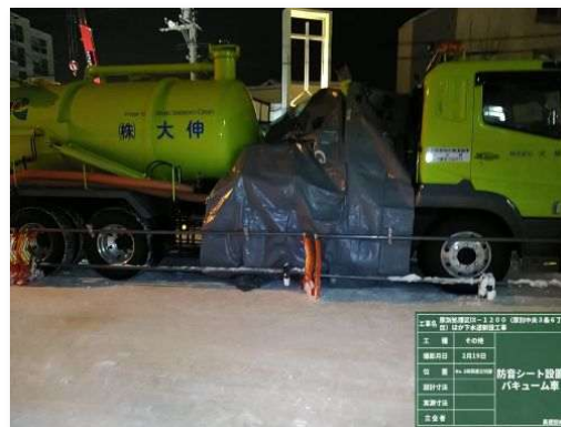
防音シートで覆い、パキユーム車の騒音を低減
