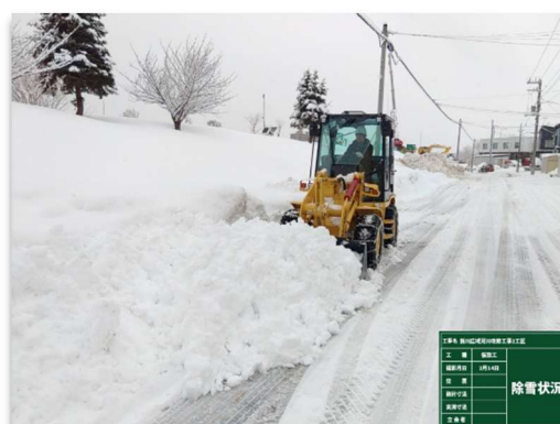
近隣の民家や工事区域外の市道を除雪
