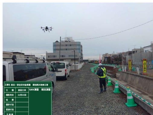
レーザードローンのよる UAV 測量
