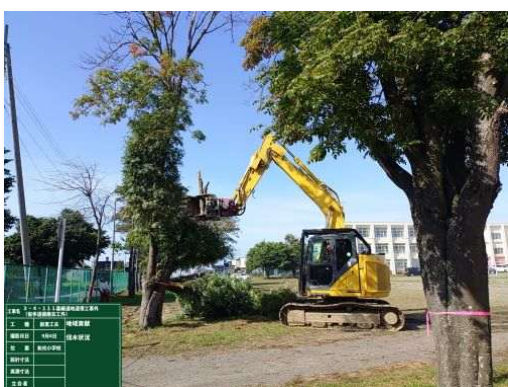
近隣小学校の樹木伐採作業
