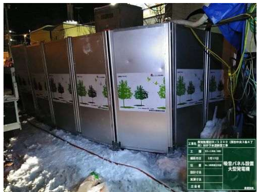
ネオ吸音パネル設置により騒音を低減
