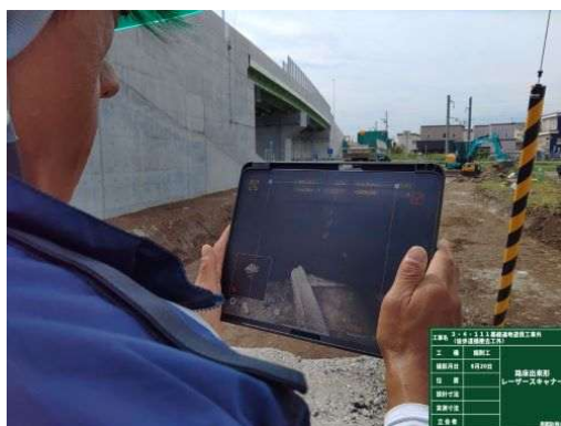
土木出来形スキャナーの活用
