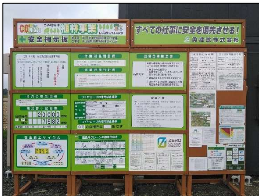
間伐材を利用した工事看板
