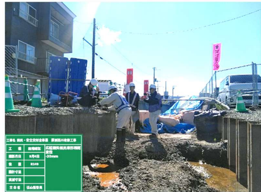
ビデオ通話を利用し発注者と遠隔にて検査を実施
