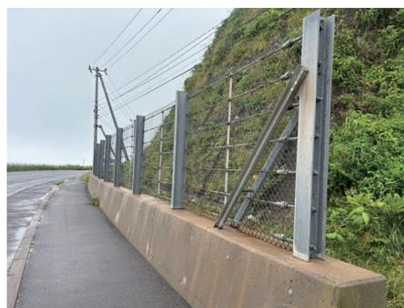
写真-1 擁壁天端に設置される従来型落石防護柵の例
