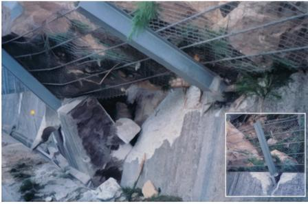
写真-2 擁壁支柱基部近傍における損傷例<sup>2)</sup>
