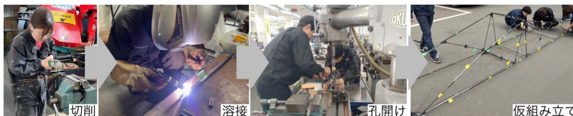
写真7 橋梁製作様子
