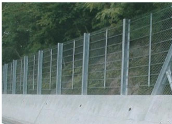
**写真 1.1** 従来型落石防護柵の一例
