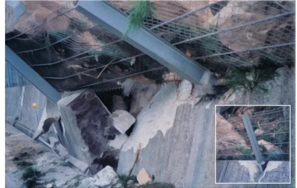
図 1.2 防護柵支柱の損傷事例<sup>2)</sup>
