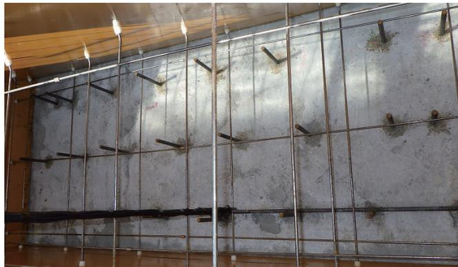
写真 2.1 擁壁底部アンカー筋設置状況
