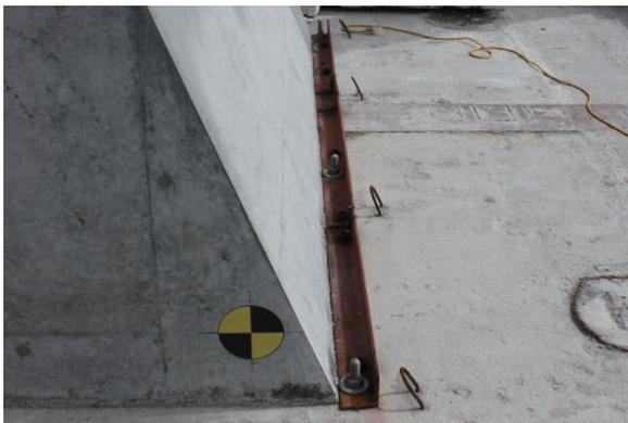
写真 3.1 L形鋼設置状況
