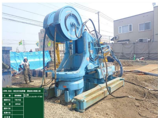
無騒音・無振動のサイレントパイラーを使用し、鋼矢板を打込み騒音・振動の発生を低減
