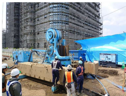
無騒音・無振動のサイレントパイラーを使用し、鋼矢板を打込み騒音・振動の発生を低減
