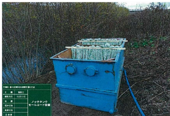
鋼製水槽内にモールコードを設置し、河川下流域への濁水流出を防止
