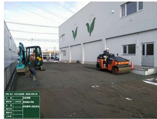
厚別小学校の駐車場の整地
