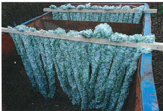
鋼製水槽内にモールコードを設置し、河川下流域への濁水流出を防止
