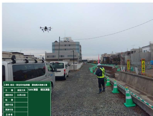
レーザードローンのによる UAV 測量
